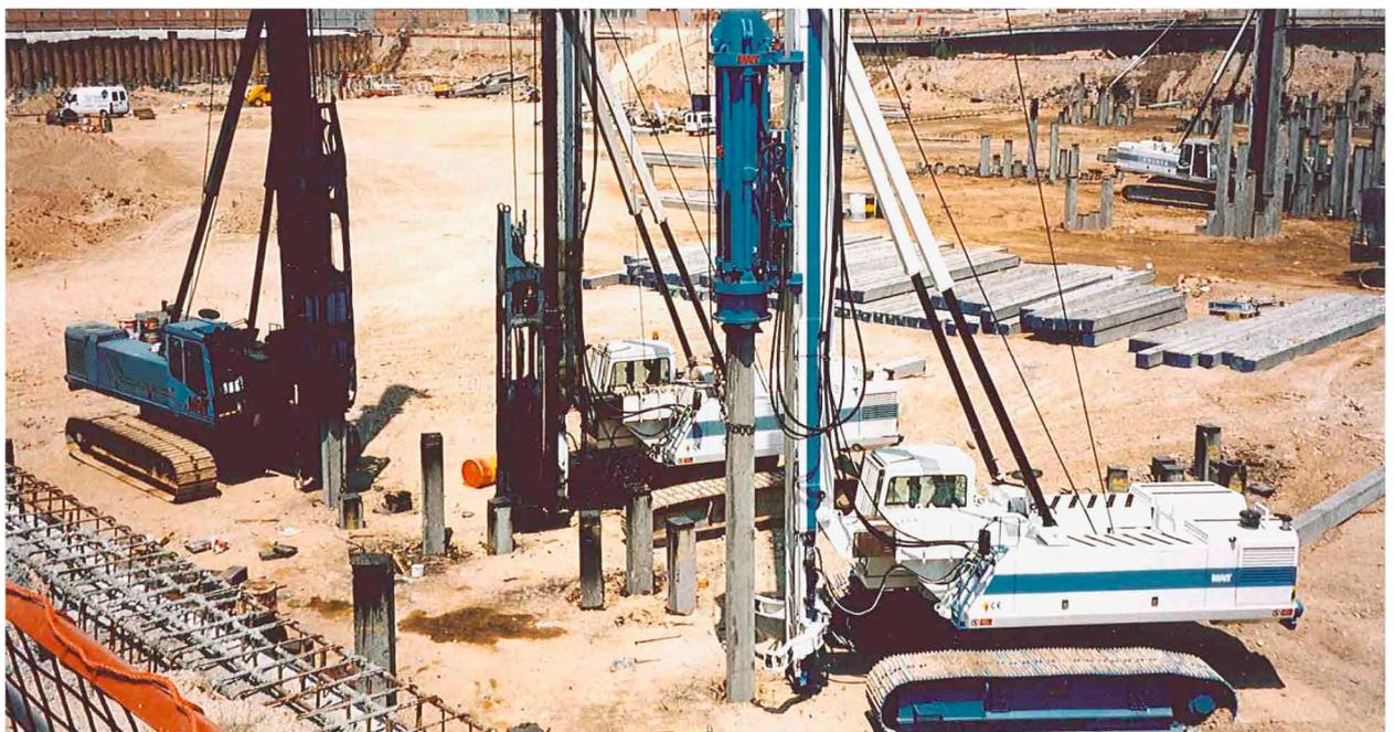
La **THH6** a été conçue pour des travaux de montage de pieux à l'aide des marteaux hydrauliques. La longueur particulière du mât permet une course considérable, idéale pour l'installation des pieux jusqu'à une profondeur de 16 m (52.5 ft.).
